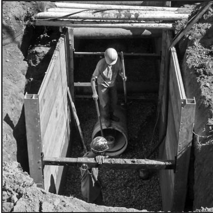
Configuración con dos lados, codales telescópicos y postes esquineros de longitud máxima
